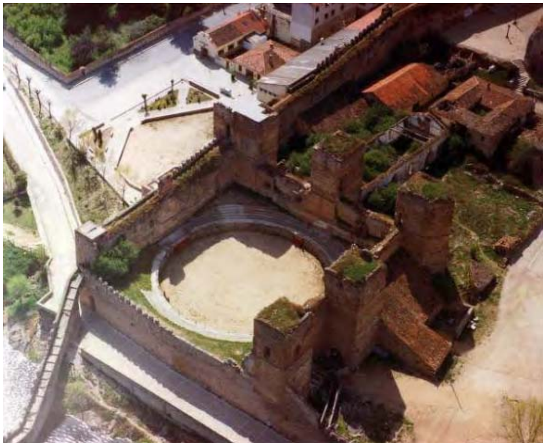
MANZANA DEL CONJUNTO DEL ESQUILEO ( Estado previo a demoliciones de Pl. Gato 1 -3 y C/ Infantado 8)
