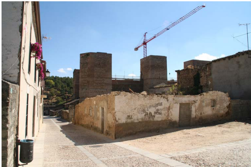
Pl. Gato nº 1 ( Estado actual)
