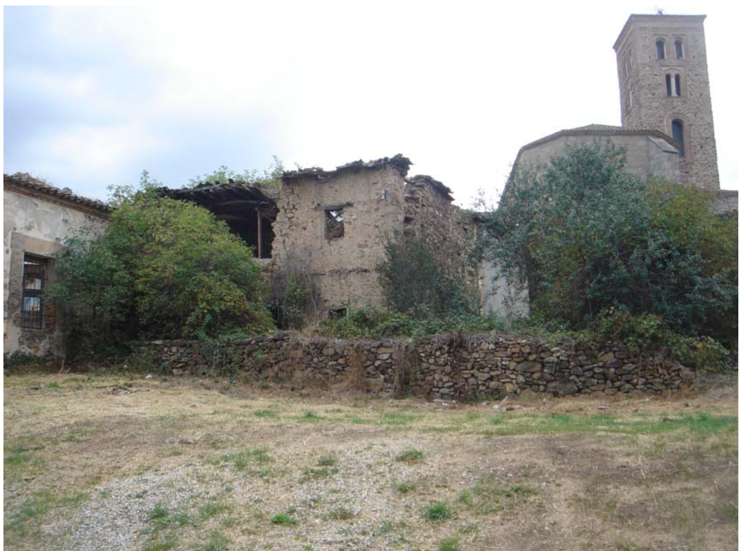
FACHADA ESTE EDIFICIO C/ INFANTADO nº 8 ( ESTADO PREVIO A DEMOLCIONES)
