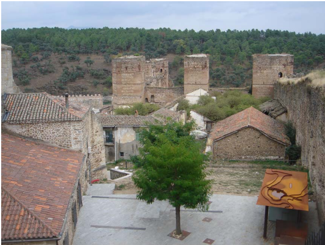
Pl. Gato nº 3 – C/ Infantado 8( Previo a las demoliciones)
