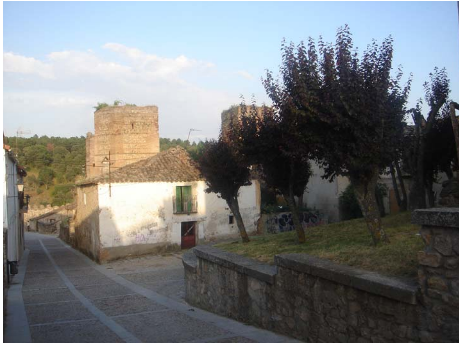
Pl. Gato nº 1 ( Previo a las demoliciones)
