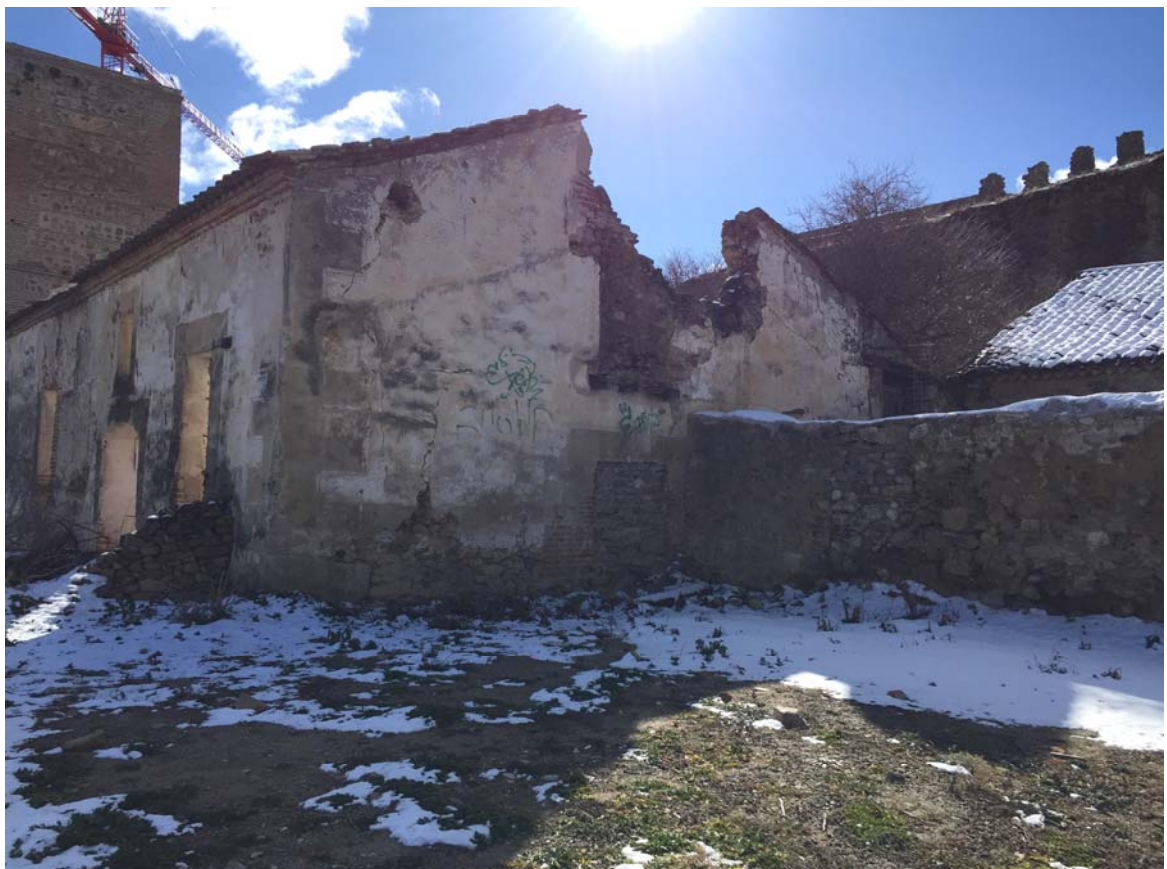
FACHADA OESTE DEL EDIFICIO DEL ESQUILEO
