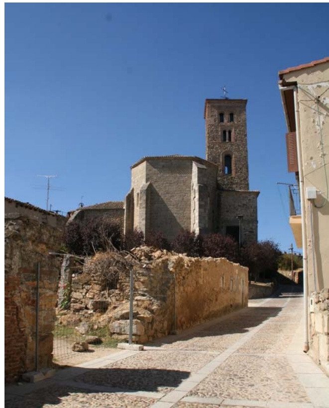
Pl. Gato nº 1 ( Estado actual)
