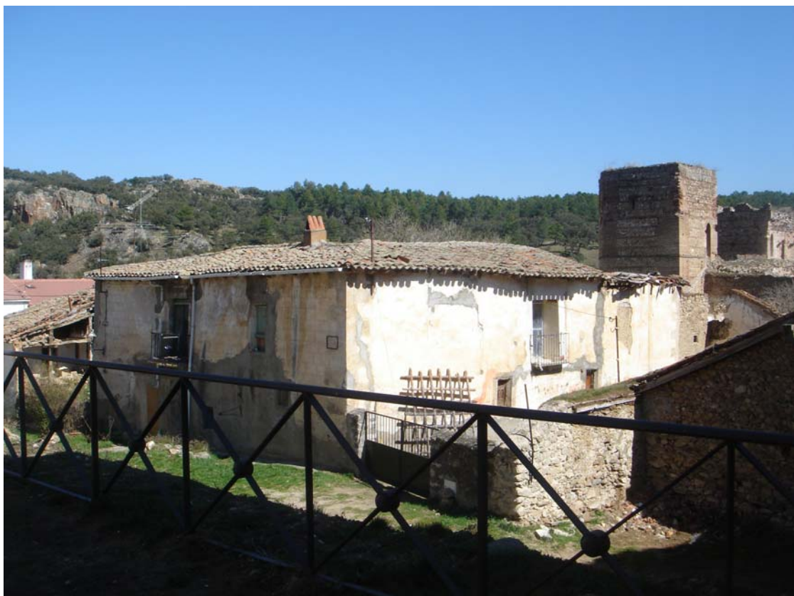
EDIFICACIÓN PLAZA DEL GATO nº 13 (Estado actual demolida)
