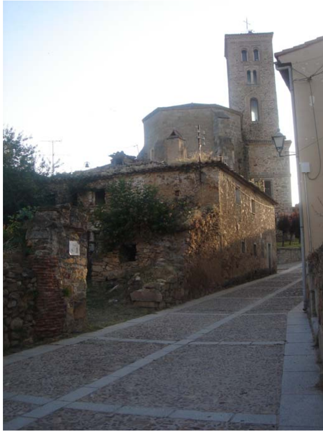
Pl. Gato nº 1 ( Previo a las demoliciones)
