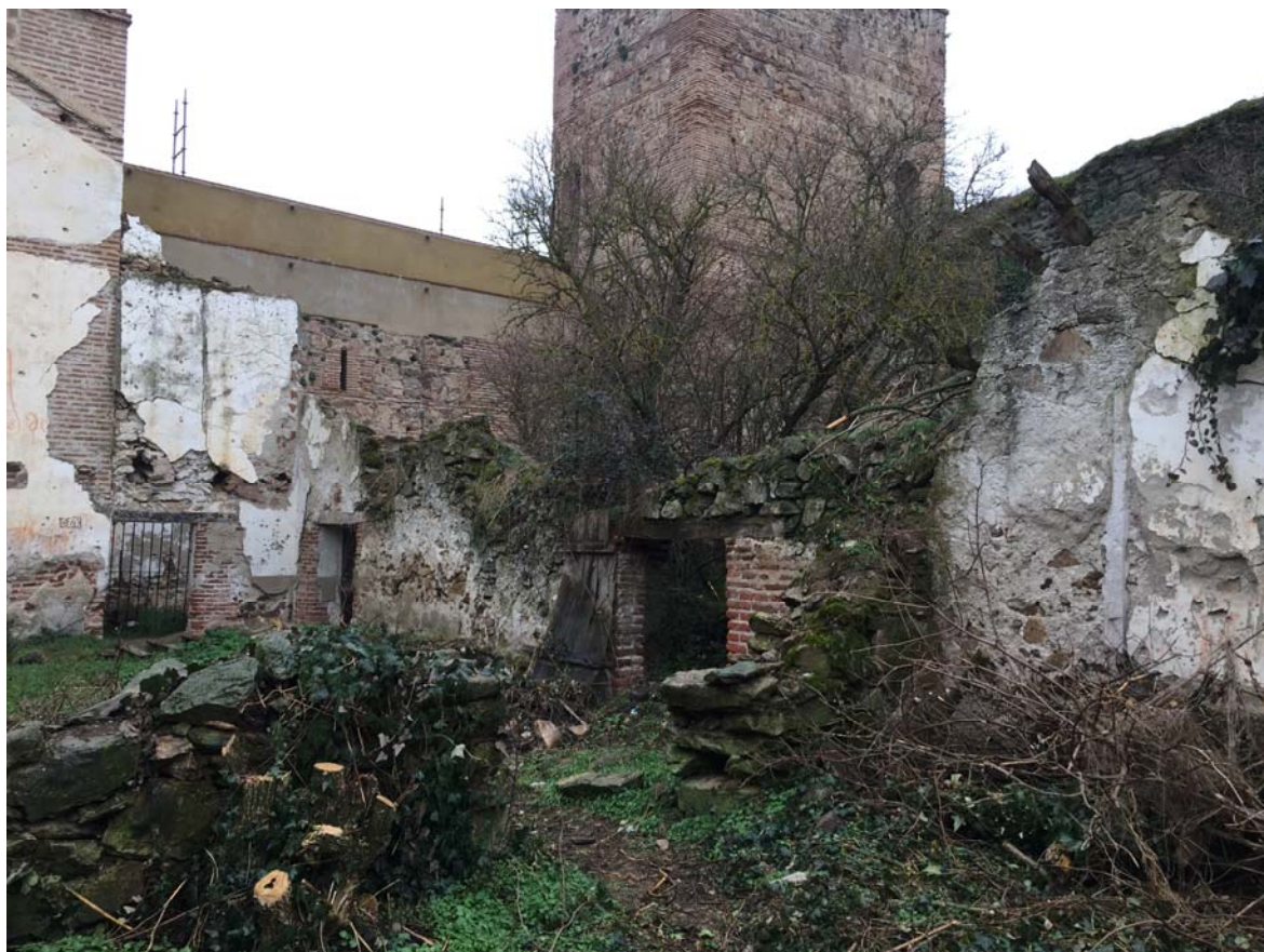
INTERIOR FACHADA SUR DEL EDIFICIO DEL ESQUILEO
