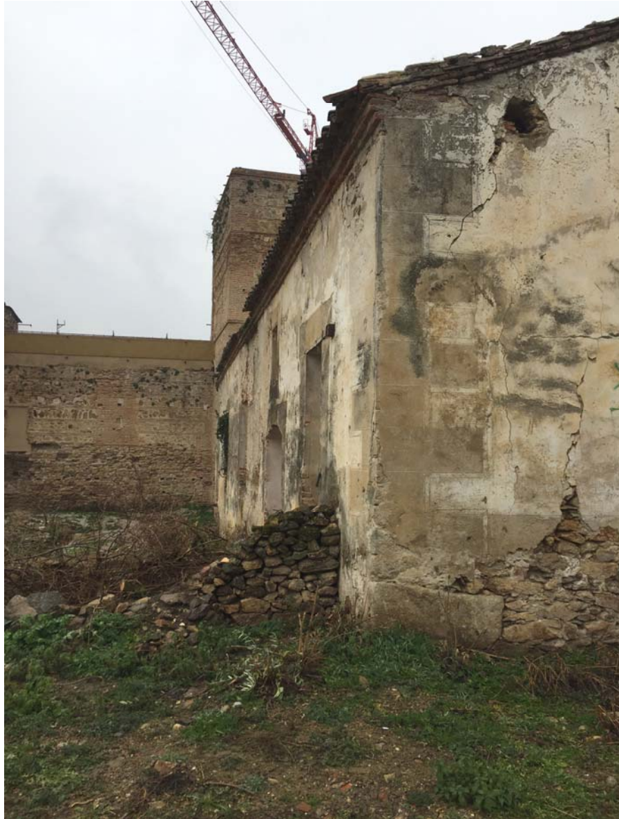
LINDERO OESTE DE LA PARCELA DEL ESQUILEO ( ESTADO ACTUAL)
