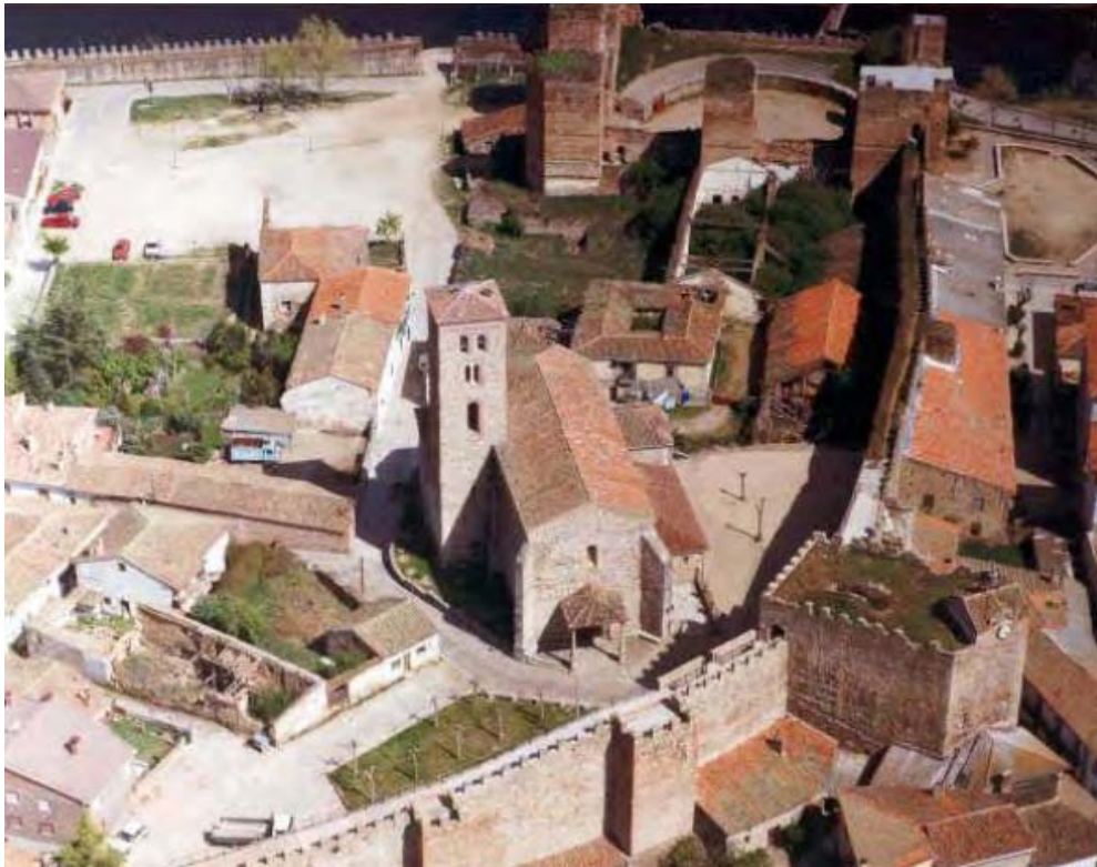
MANZANA DEL CONJUNTO DEL ESQUILEO ( Estado previo a demoliciones de Pl. Gato 1- 3 y C/ Infantado 8)
