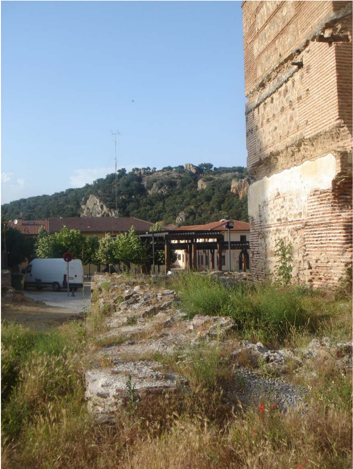
LINDERO ESTE CON EL ANTEMURO DEL CASTILLO DE LOS MENDOZA
