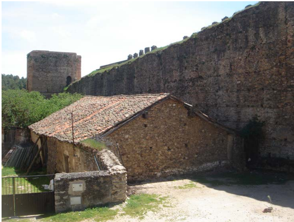
Pl. Gato nº 4 ( Estado actual)
