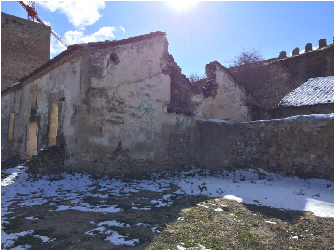
FACHADA OESTE EDIFICIO DEL ESQUILEO ( ESTADO ACTUAL)
