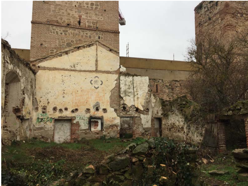
TESTERO ESTE DEL EDIFICIO DEL ESQUILEO
