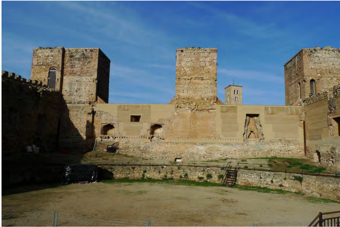
Vista interior del lienzo oeste desde intramuros. 2014.
