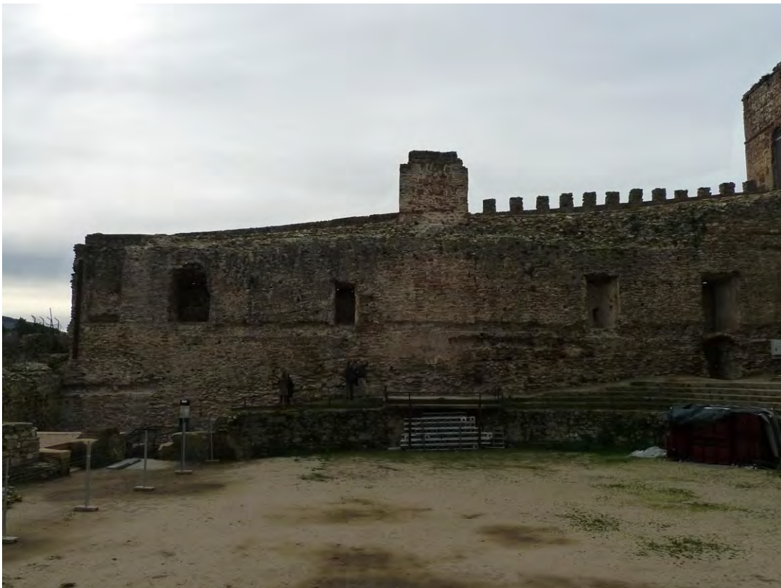
Vista interior del lienzo sur desde intramuros. 2014.
