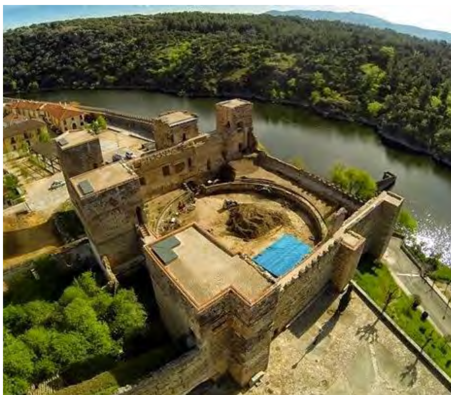
Vista aérea del Castillo de Buitrago en 2014. La plataforma azul corresponde a uno de los eventos celebrados en su interior. Se observan las azoteas de las torres reparadas, con sus trampillas de acceso recubiertas con zinc.
